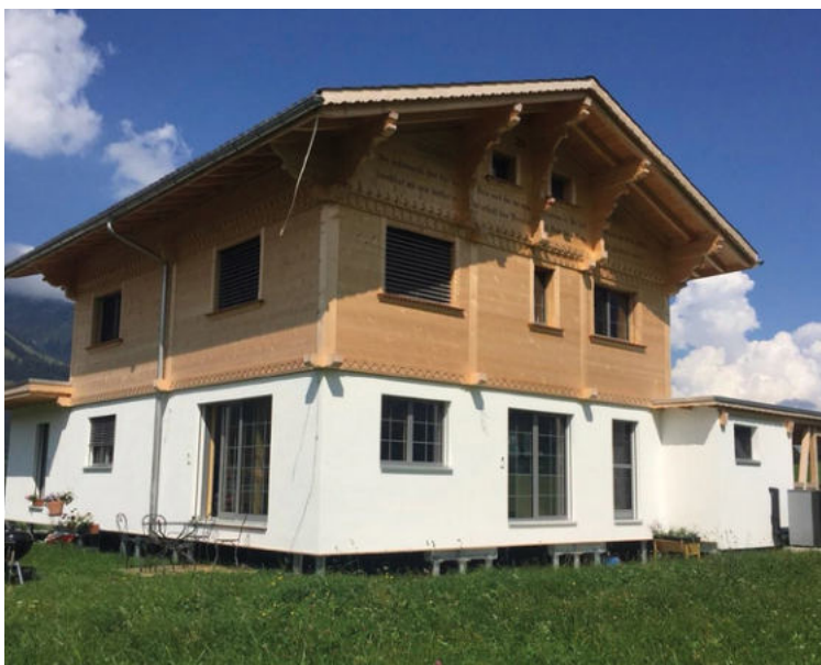
Einfamilienhaus, kurz vor Erstellung einer umlaufenden Terrasse
