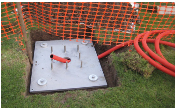
Mastfundament für Kandelaber
