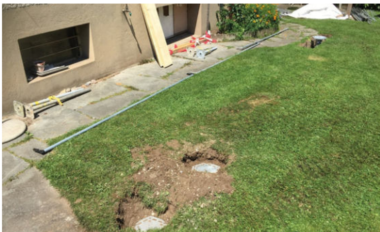
Schraubfundamente für Balkonstützen
