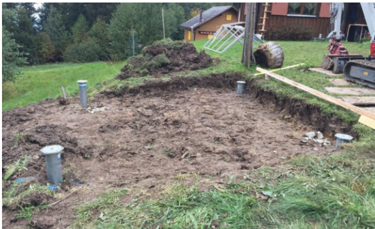
Schraubfundamente für Gartenhaus
