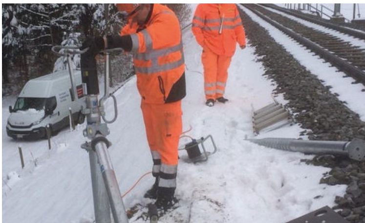
Einbau Schraubfundamente für Kleinmast
