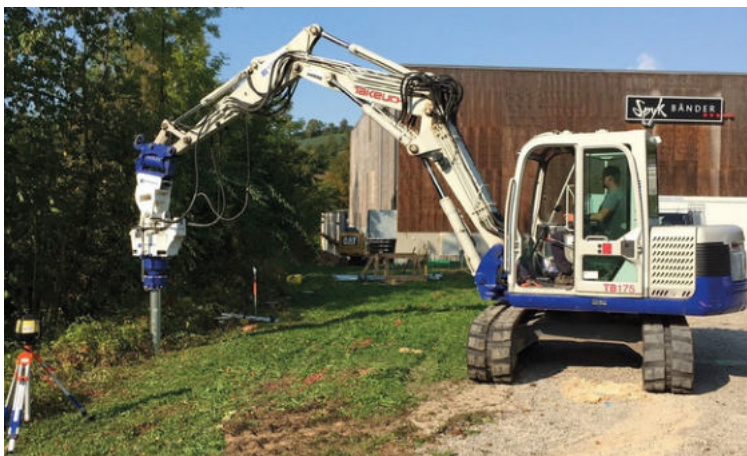
Einbau Schraubfundamente für Büroprovisorium
