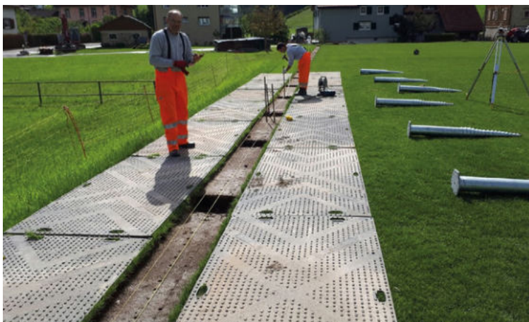
Einbau Schraubfundamente für Ballfangzaun
