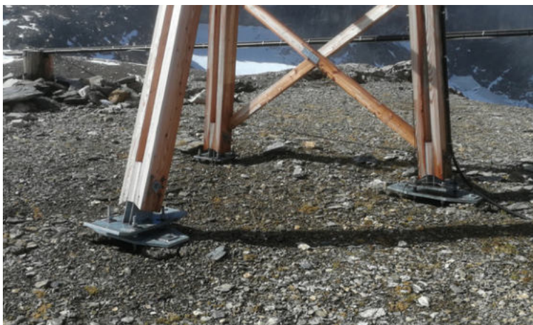
Fundamente für Windrad
