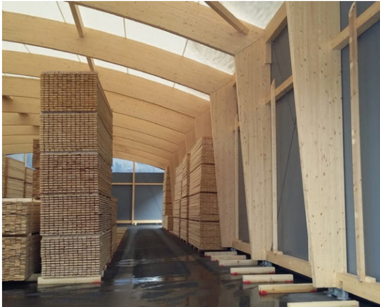
Halle für Holzlager
