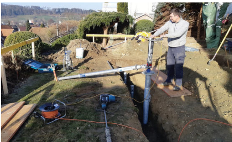
Fundamentbau in Aufschüttung für Wintergarten
