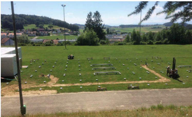
Einbau Schraubfundamente für Containerprovisorium
