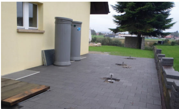
Schraubfundamente Serie F-R mit Pfostenträger, bereit für Aufrichte Carport
