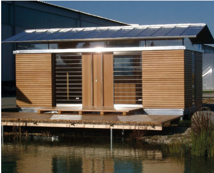
Gartenhaus mit Terrasse auf Schraubfundamenten
