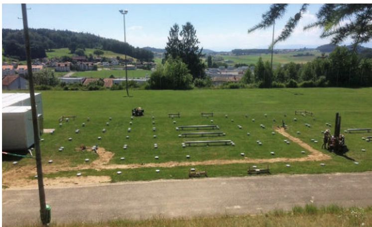
Einbau Schraubfundamente für Erweiterung Schulprovisorium
