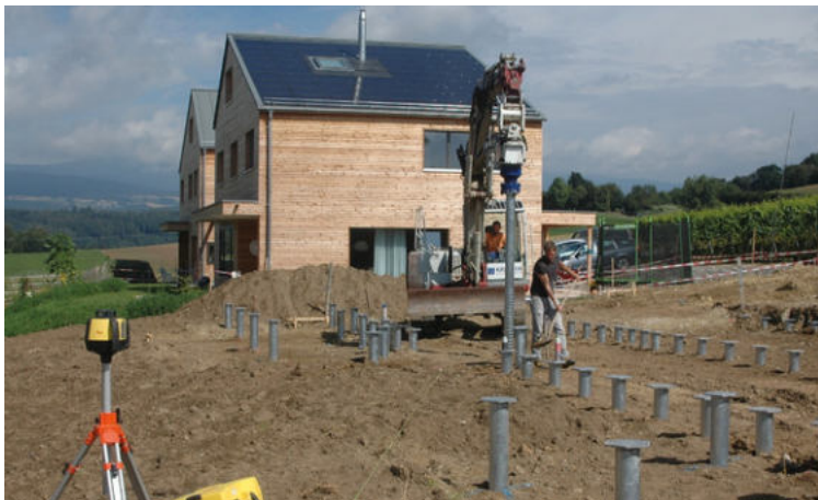
Einbau Schraubfundament für Doppelfamilienhaus
