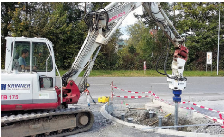
Einbau Schraubfundamente für 10m Pylon
