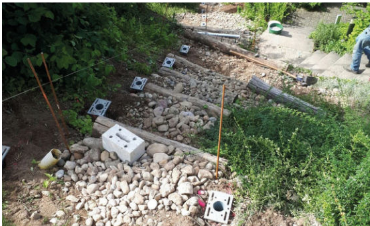
Schraubfundamente für Treppenlift
