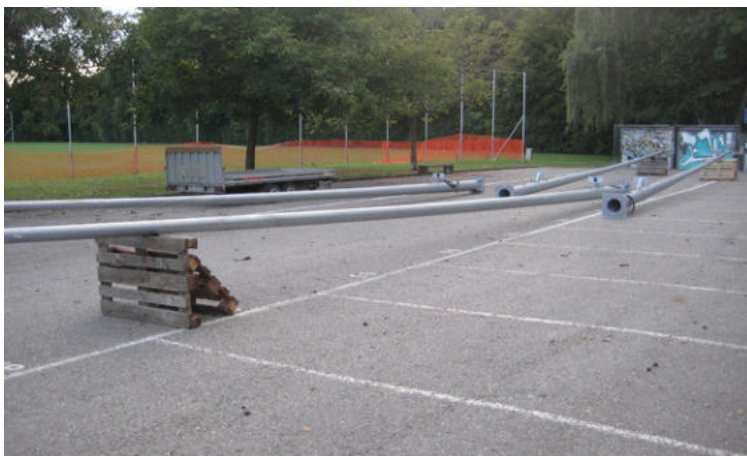
Bereitgestellte Masten für die Montage
