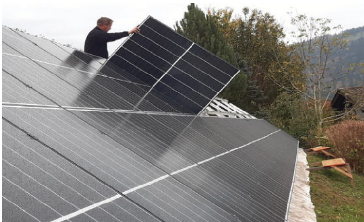
Die Solarpanels werden auf den Schienen platziert
