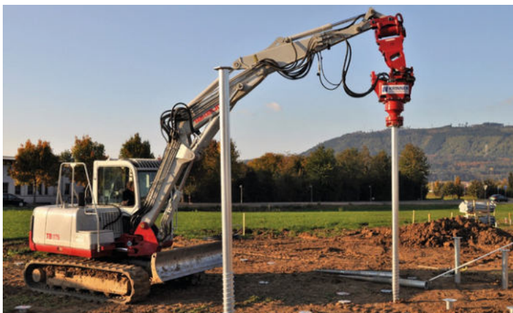
Einbau Schraubfundamente mit Bagger und Anbaugerät
