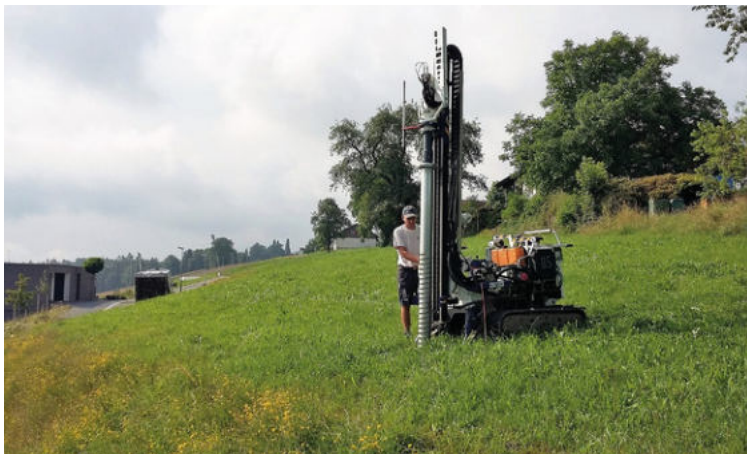
Einbau Schraubfundamente für EFH
