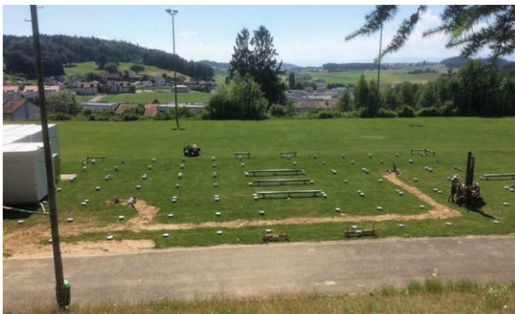
Einbau Schraubfundamente für prov. Schule
