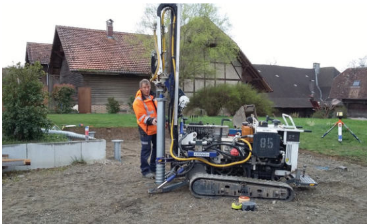
Einbau Schraubfundamente
