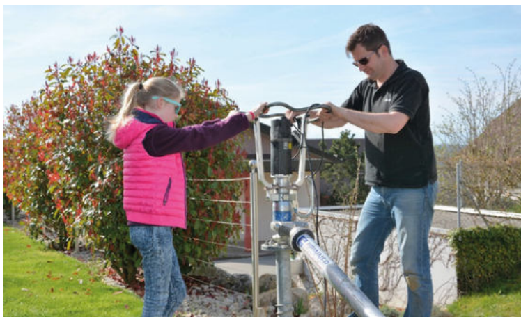
Einbau Schraubfundamente mit Elektromaschine
