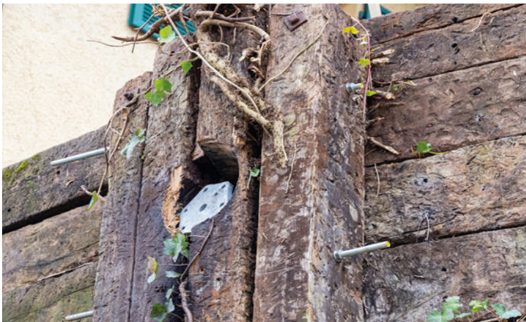
Hangsicherung in Wohnquartier
